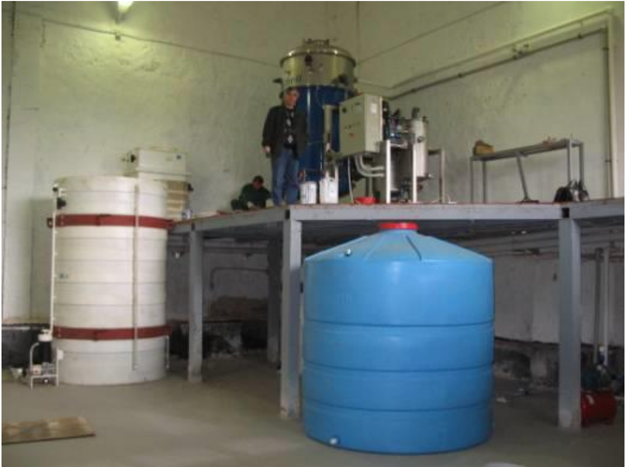
Калуга. Цех очистки стоков на базе вакуумной выпарной установки Escoprima 5000 - CR/WS . Слева танк для накопления обрабатываемых стоков, справа танк для дистиллята.
